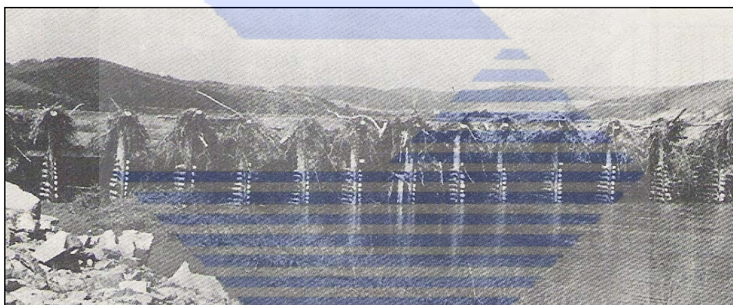
Obr. 11.2: Plovoucí předměty zachycené na ochranných bárkách při povodni
